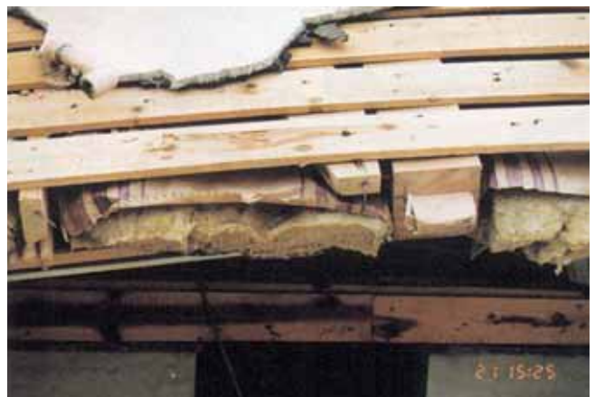
金物補強のない接合部(柱脚 土台)の抜出し
