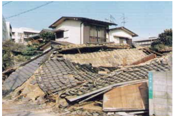
耐力不足と老朽化で完全に倒壊した住宅
