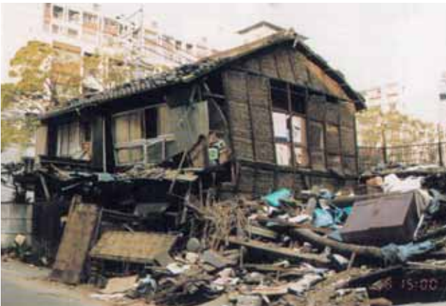
古い構法による被害
