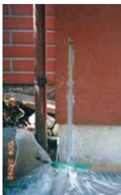
< 1階と2階の柱の緊結 >
