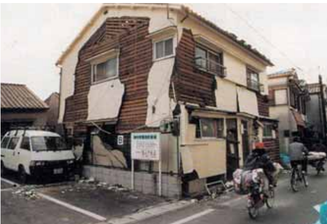
外壁モルタルの剥落
