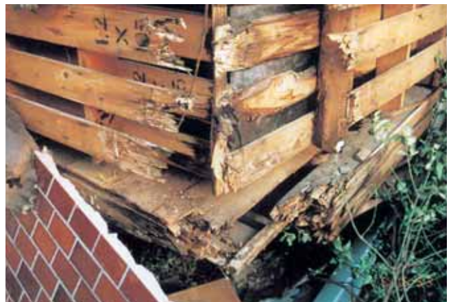
軸組の腐朽・蟻害
