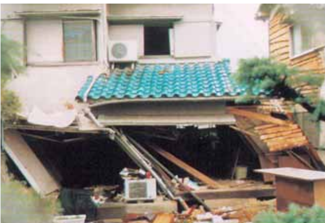
壁量不足で大傾斜した住宅
